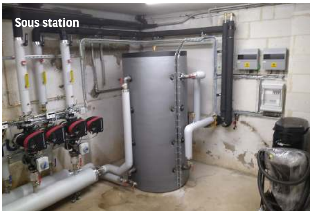
Livraison et installation chaufferie
