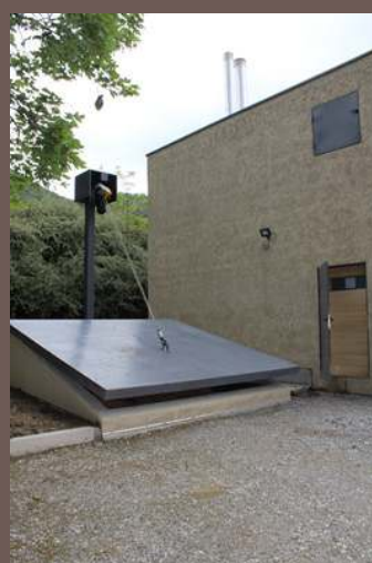
Extérieur de la chaufferie
