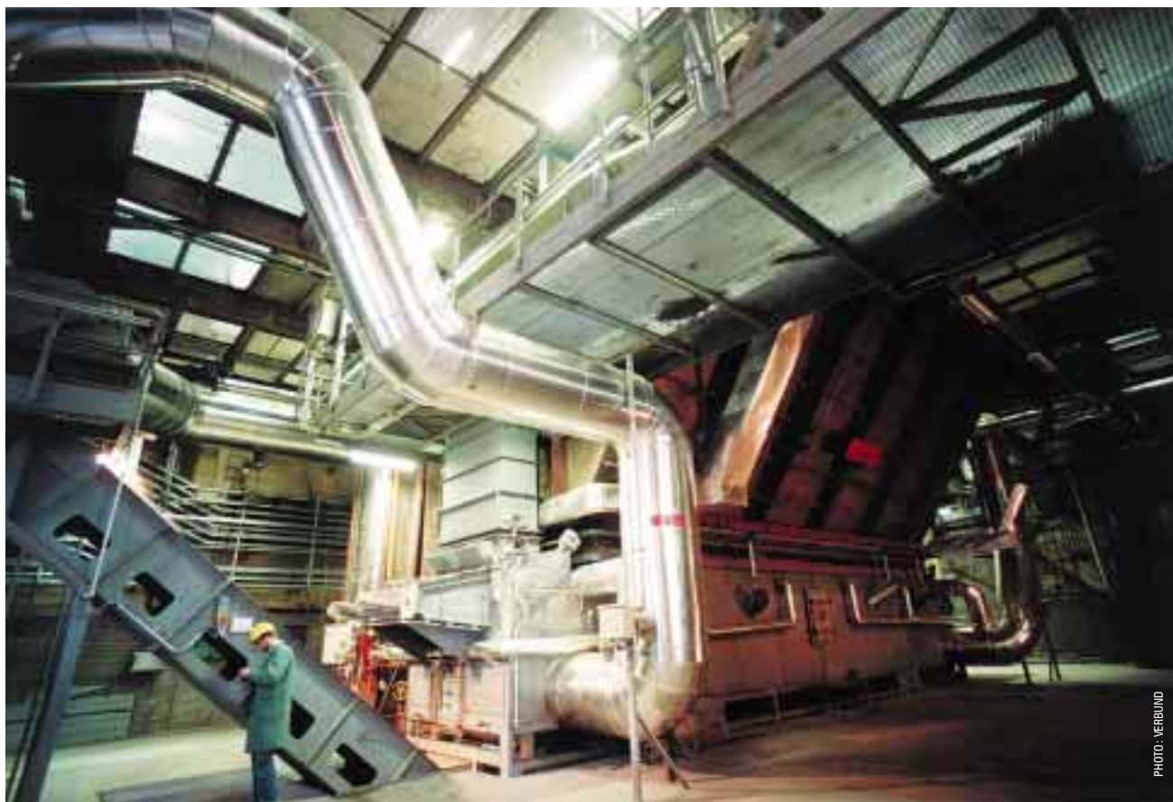
Bild 3: Der Mitverbrennungsrost für Biomasse im Dampfkraftwerk St. Andrä.
