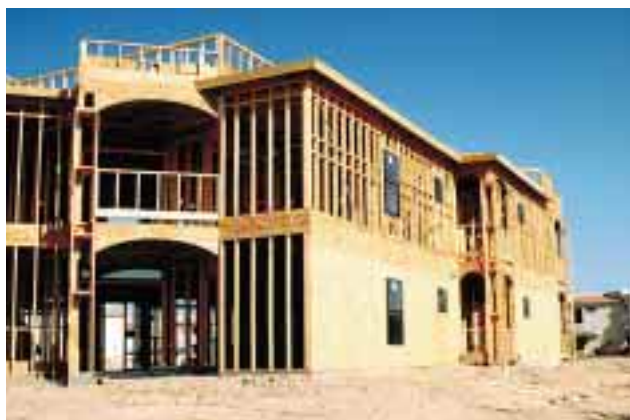
La plupart des constructions américaines est réalisée en bois. Die meisten amerikanischen Bauten sind aus Holz.
