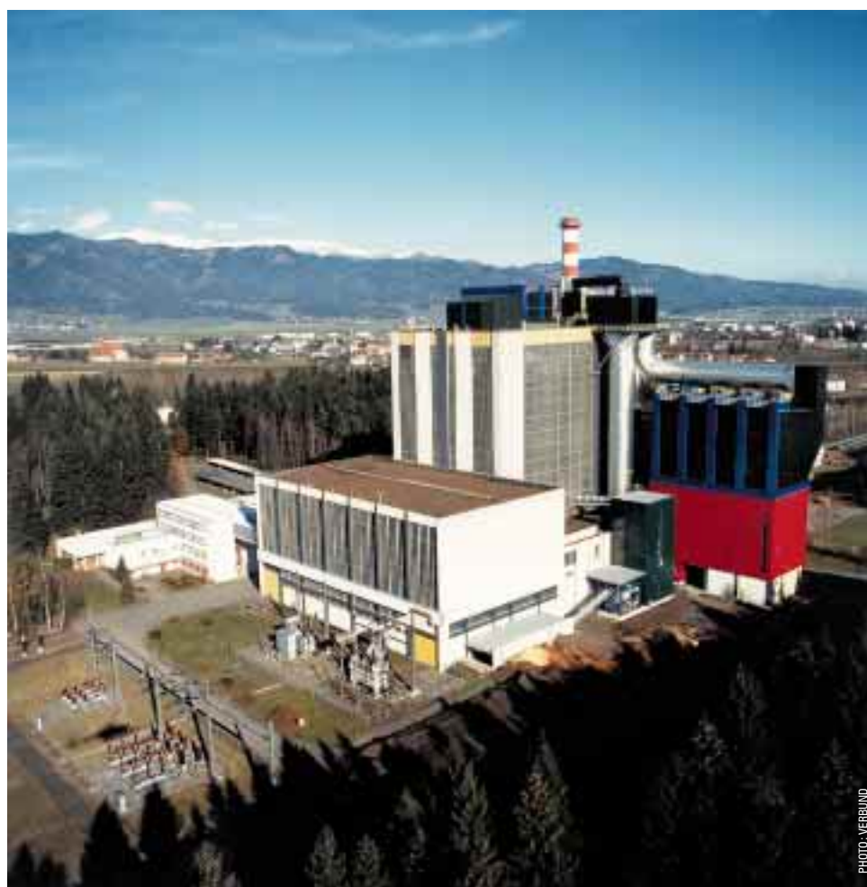
Bild 7: Komplettansicht vom Kraftwerk Zeltweg mit Biomasselagerplatz.
