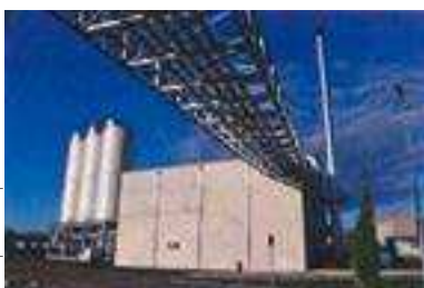
Boisseaux de biocombustible chaudière et tuyauteries d'eau chaude sur rack
