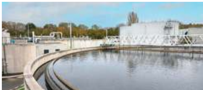
Station d'épuration de Bourge Plus (18)
