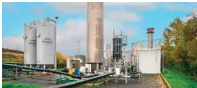
Centre d'enfouissement de Saint-Palais (18)
