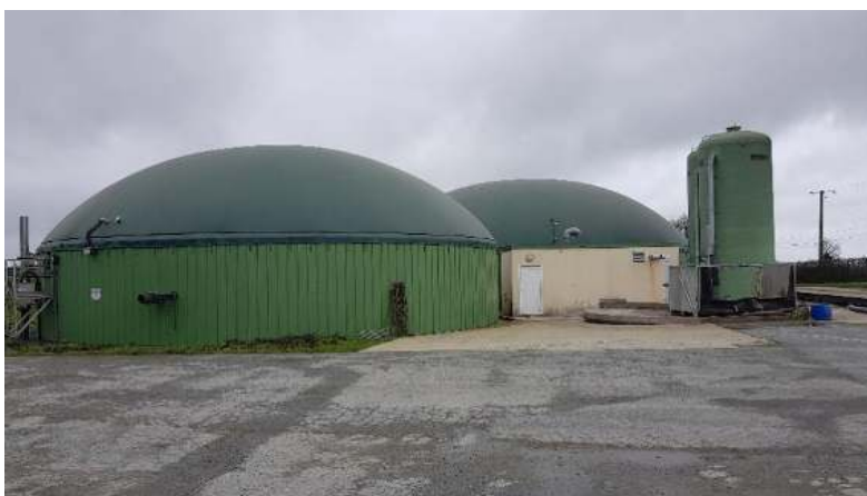
Figure 3 : post-digesteur (à gauche) et digesteur (à droite)
