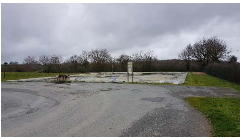
Figure 4 : poche à digestat liquide
