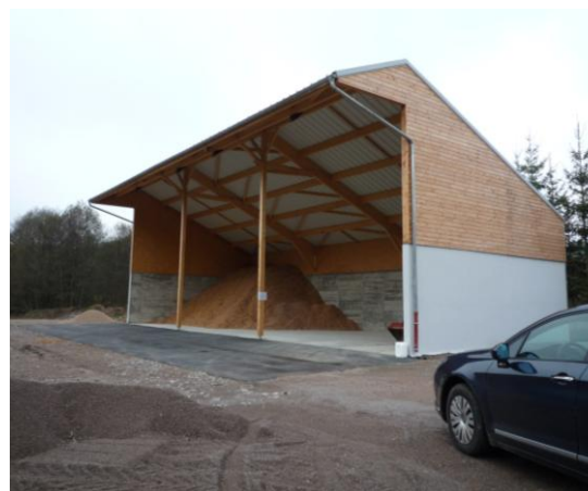
Plateforme de stockage : aire goudronnée et bâtiment
