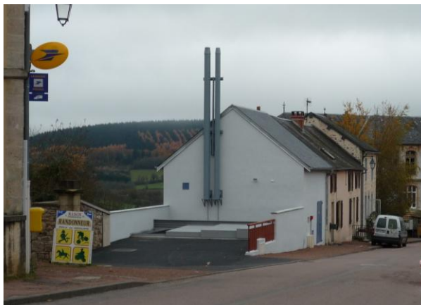
Chaufferie et silo
