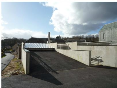
Le silo est d'une capacité totale de 90 m<sup>3</sup> (5 m de long, 5 m de large et x 3,6 m de haut), soit environ **63 m<sup>3</sup>** utiles, permettant une **autonomie moyenne** sur la saison de chauffe **d'environ 30 jours**, et nécessitant **1 à 2 livraisons de 30 MAP** tous les 15 jours en plein hiver, en camion de 30 m<sup>3</sup> uniquement.
