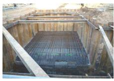
Le silo est d'une capacité totale de 160 m³ (8 m de long, 5,6 m de large et 3,5 m de haut), soit environ **100 m³** utiles, permettant une **autonomie moyenne** sur la saison de chauffe **de 12 jours**, et nécessitant **2 livraisons par semaine** en plein hiver.
