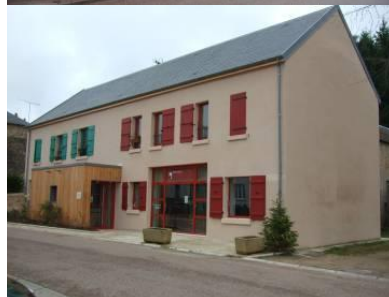
Bâtiment après réhabilitation
