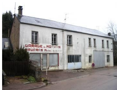
Bâtiment avant réhabilitation
