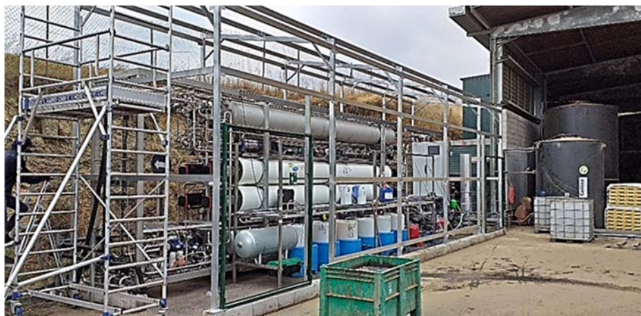
Figure 18 : Installation du dispositif de fractionnement du digestat VALORDIG sur site client
