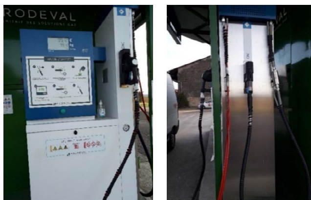
Figure 3: Borne de distribution sur la station bioGNC EurekaIias raccordée à l'unité de méthanisation de M. Colin (Haute-Marne) – photo AKAJOULE
