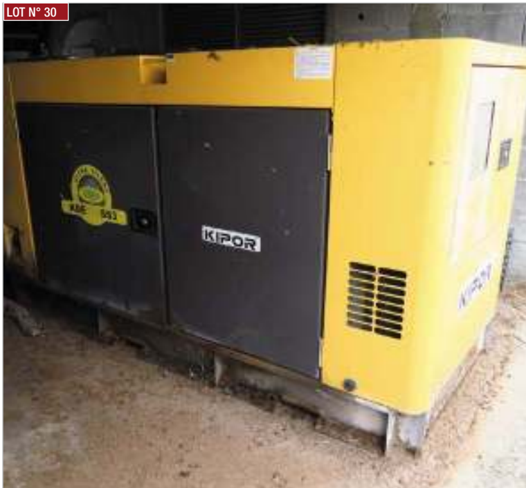
► Groupe électrogène KIPOR , type KDE 100 SS3, puissance 80 KVA, fréquence 50 HZ, voltage nominal 230/400 V, courant nominal 115 A, énergie diesel ► KIPOR generator, type KDE 100 SS3, power 80 kVA, frequency 50 Hz, nominal voltage 230/400 V, nominal current 115 A, diesel power
