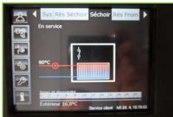
Gestion de l'ensemble des circuits de chauffage par la régulation de la chaudière
