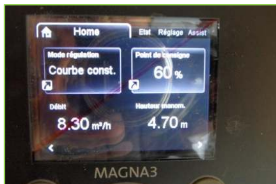
Ecran des circulateurs haut rendement, lecture du mode de fonctionnement et des performances
