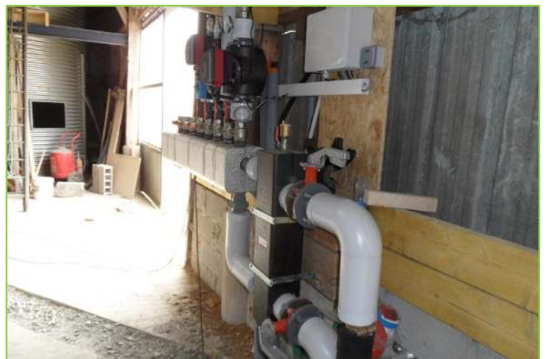
Installation d'un répartiteur 4 circuits dans la sous station séchoir.
