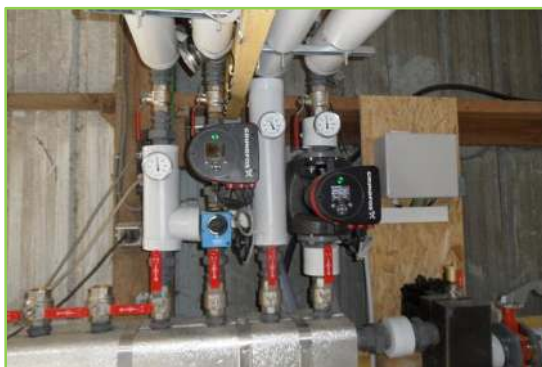
Gestion de l'ensemble des circuits de chauffage par la régulation de la chaudière
