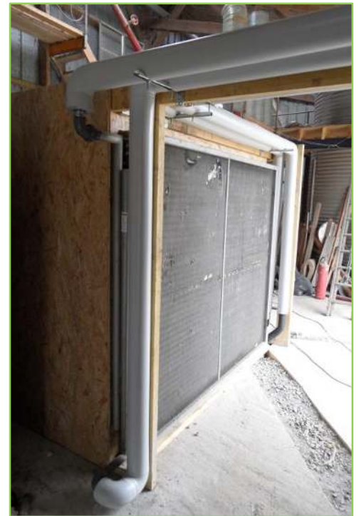
Raccordement d'une batterie eau chaude existante pour le séchage du fourrage
