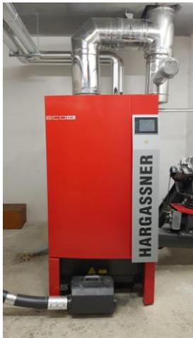
Truffée de sondes de contrôle pour la température, l'humidité de l'air, humidité du bois, les teneurs en gaz, la combustion des plaquettes est quasi-complète.
