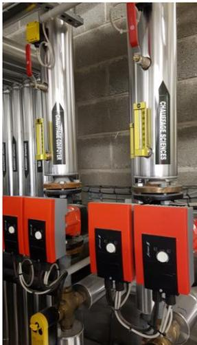
Des vannes et des circulateurs (petits moteurs rouges qui font circuler l'eau en continu vers les radiateurs) permettent de répartir l'eau de chauffage vers différentes zones du collège comme les salles de sciences, l'administration, salles 01 à 08 ...
