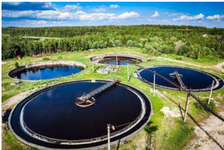
Figure 12 : Vue d'une station d'épuration de boues urbaines
