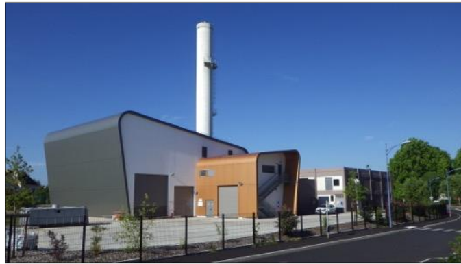
Photos chaufferie : M.Valarcher Dalkia/SOFLEC
