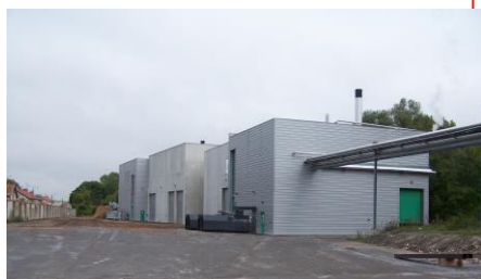
Chaudière biomasse 2 en arrière plan
