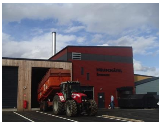
La chaufferie de Neufchâtel-en-Bray présente un taux de couverture biomasse de 90 %.
