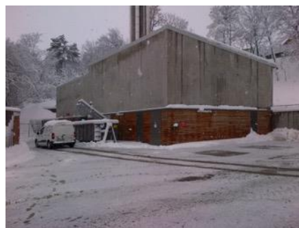
La chaufferie du centre hospitalier en plein hiver.
