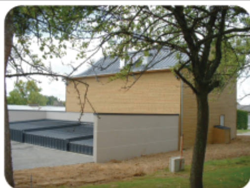
La chaufferie et son silo
