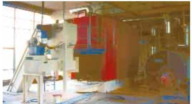
Chaudière automatique au bois, au premier plan le convoyeur à échelles du bois déchiqueté ainsi que le pousoir pour l'alimentation de la chaudière.
