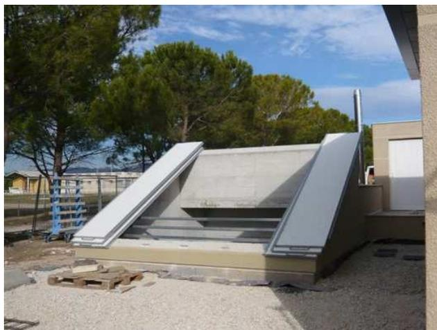
Image 2 : Trappe basculante du silo semi enterré
