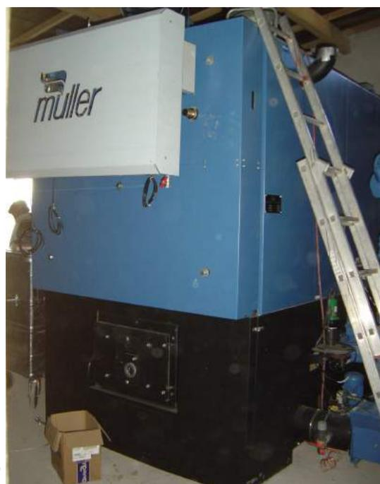
Photo 1 : Chaudière automatique au bois de 550 kW
