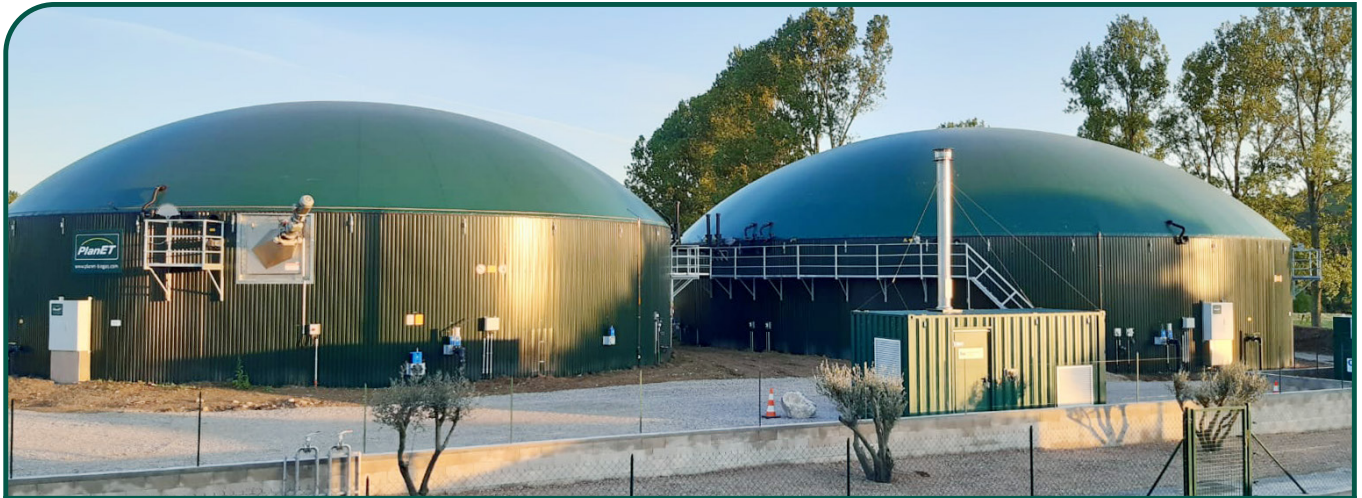
Capacité d'épuration: 170 Nm 3 /h de biométhane | Mise en service: Mai 2021
