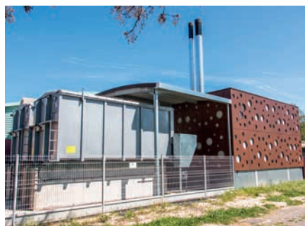
Silo hors sol constitué de 2 bennes accolées à la chaufferie
