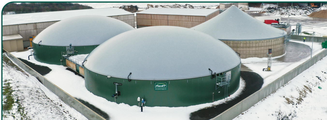
Taille de l'installation: 499 kW | Mise en service: Mars 2020
