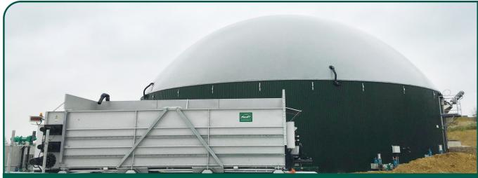
Capacité d'épuration: 120 m³ évolutive à 150 m³ biogaz/h | Mise en service: Avril 2021
