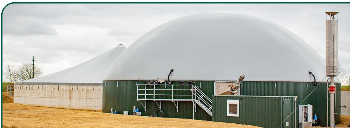
Taille de l'installation: 250 kW | Mise en service: Avril 2021
