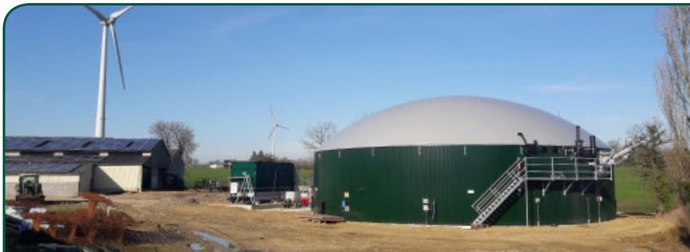
Taille de l'installation: 250 kW | Mise en service: Février 2019
