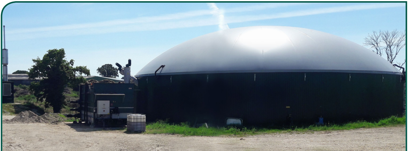
Taille de l'installation: 250 kW | Mise en service: Avril 2016
