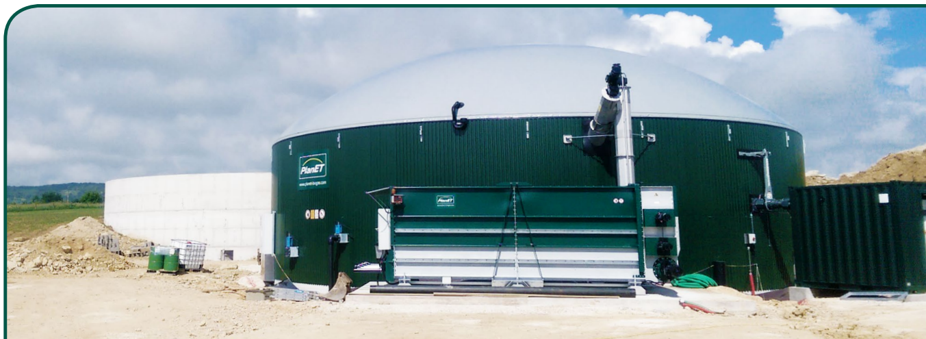
Taille de l'installation: 160 kW | Mise en service: Août 2018
