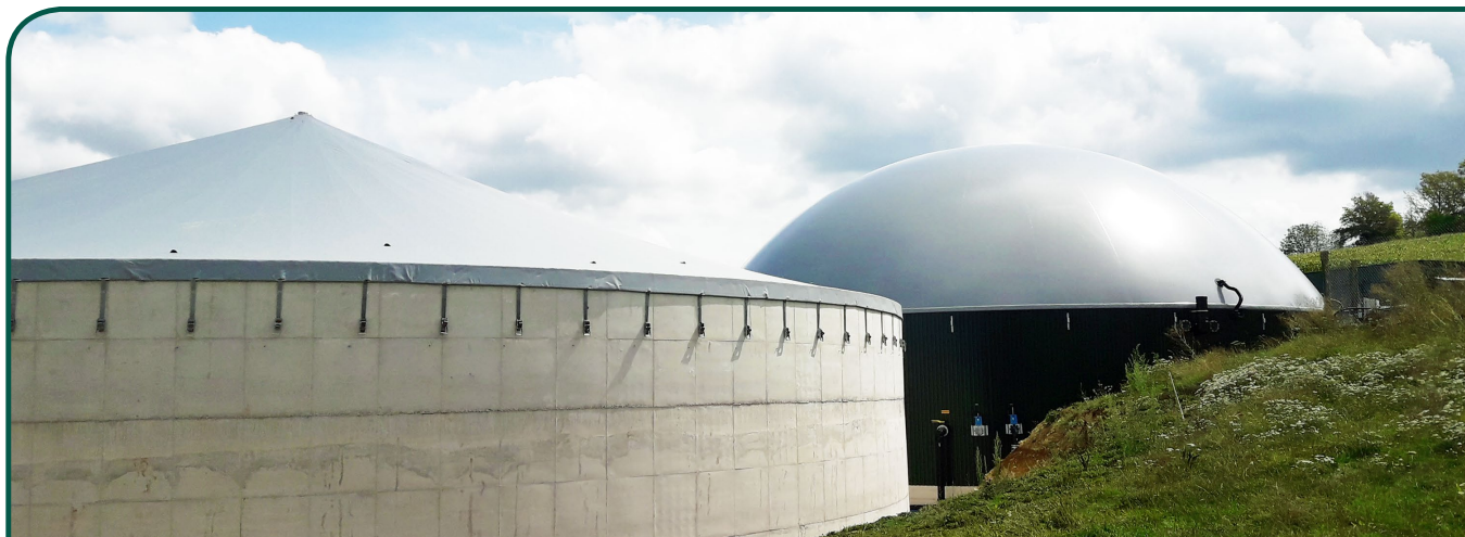
Taille de l'installation: 250 kW | Mise en service: Octobre 2019
