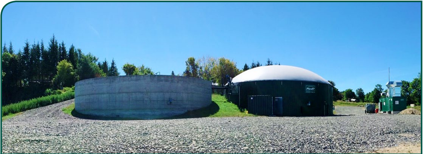
Taille de l'installation: 160 kW | Mise en service: Octobre 2019
