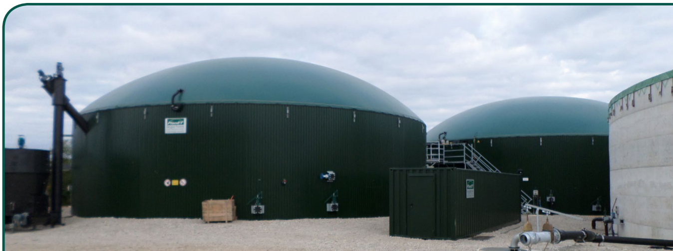
Taille de l'installation: 340 kW | Mise en service: Septembre 2015
