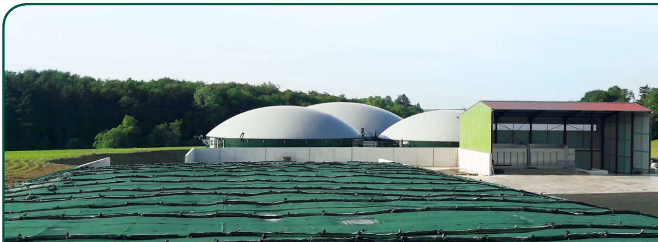
Capacité d'épuration: 260 m 3 biogaz/h | Mise en service: Août 2018
