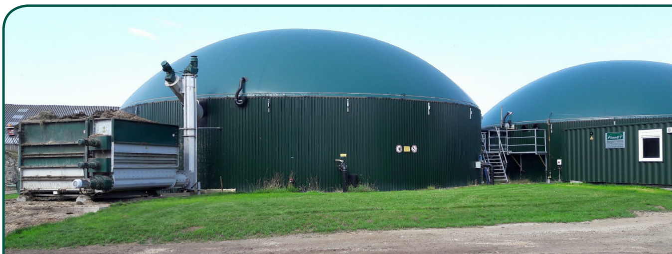
Taille de l'installation: 220 kW | Mise en service: Octobre 2014
