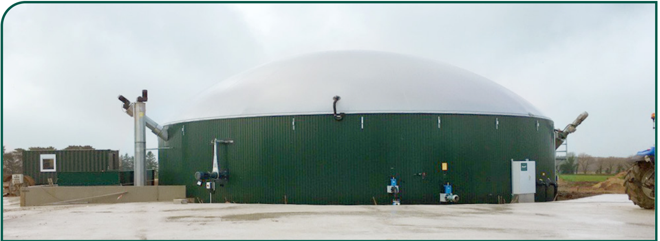
Capacité d'épuration: 140 m 3 biogaz/h | Mise en service: Mars 2021
