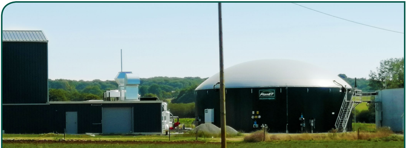
Taille de l'installation: 160 kW | Mise en service: Mai 2019
