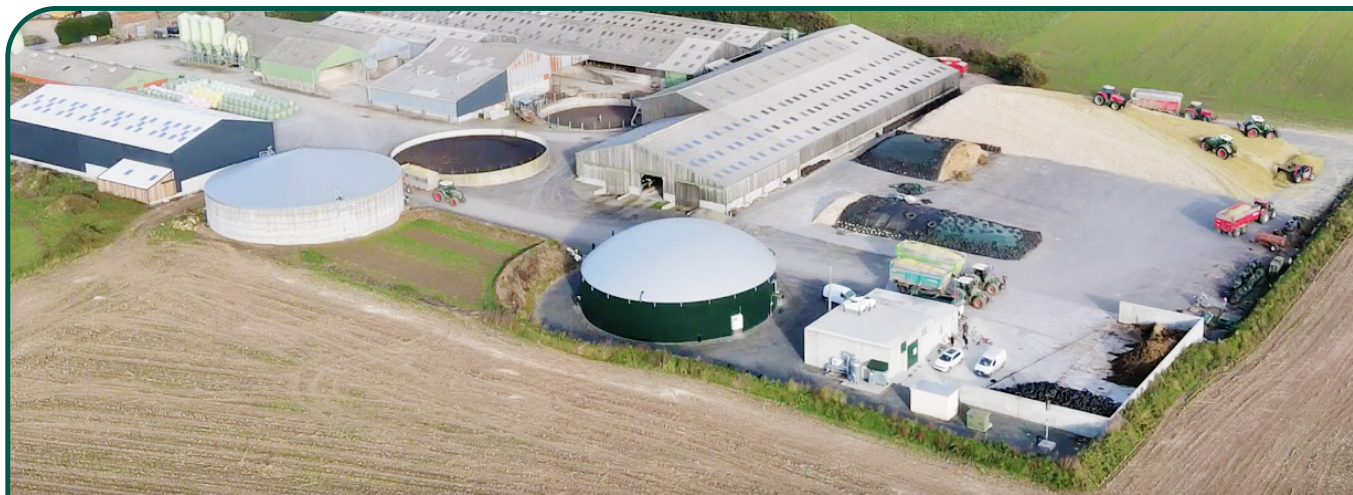
Taille de l'installation: 250 kW | Mise en service: Avril 2019
