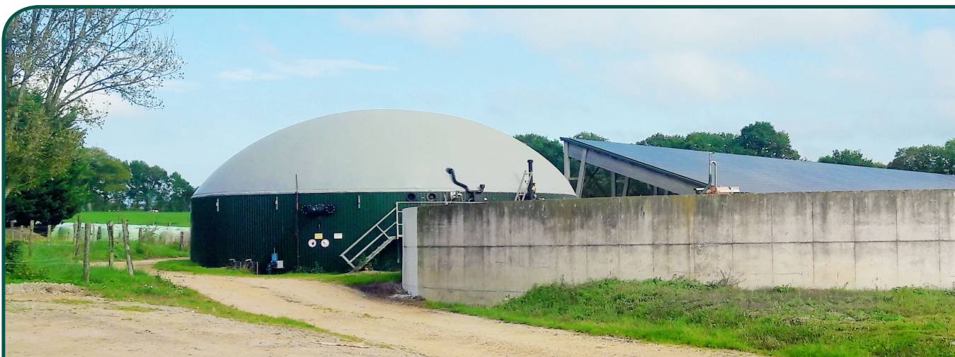
Taille de l'installation: 210 kW | Mise en service: Juin 2012 | Repowering/Extension: 2019
