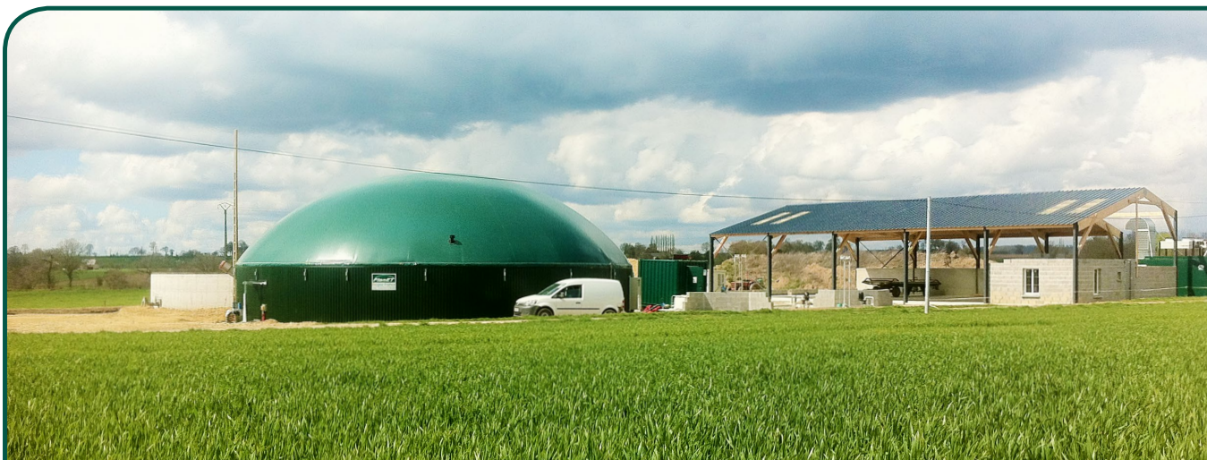
Taille de l'installation: 220 kW | Mise en service: Juillet 2012
