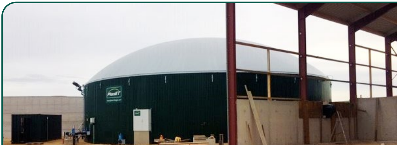
Taille de l'installation: 250 kW | Mise en service: Décembre 2019
