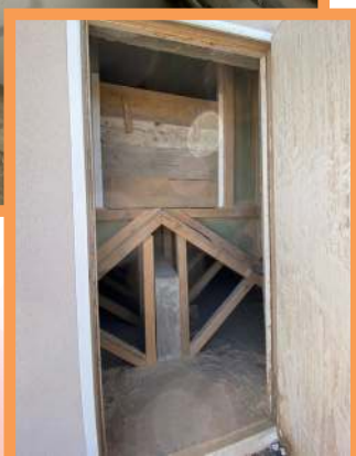
Double silo 'en dur' à 2 pentes
