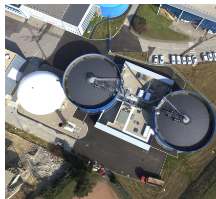
Vue aérienne de la méthanisation
