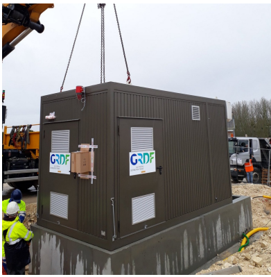
Livraison du poste d'injection
