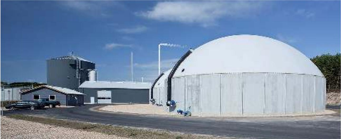
La méthanisation a l'avantage de produire à la fois une énergie renouvelable (le biogaz) qui peut être valorisé dans une unité de cogénération (chaleur et électricité) ou bien être épuré en biométhane (injectable dans le réseau de gaz naturel ou utilisé comme carburant) et de produire un digestat pouvant être valorisé en amendement sur les terres agricoles.
