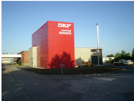
La chaufferie bois
