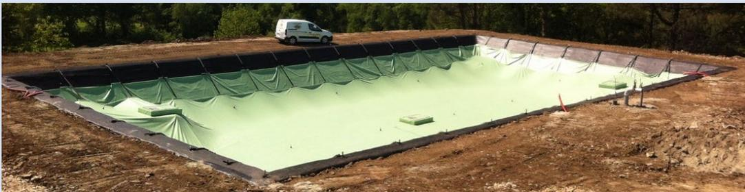
Photo 13 : Citerne souple semi-enterrée en pointe de diamant inversée (Source : Labaronne-Citaf).
