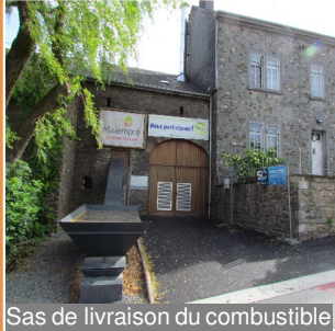
Sas de livraison du combustible
