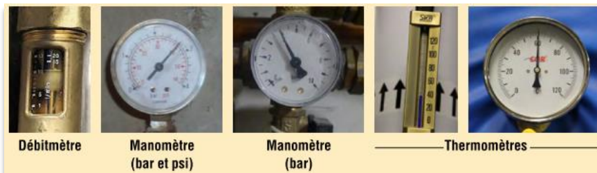
source : SOCOL installations Solaire Thermique collectives en copropriété
