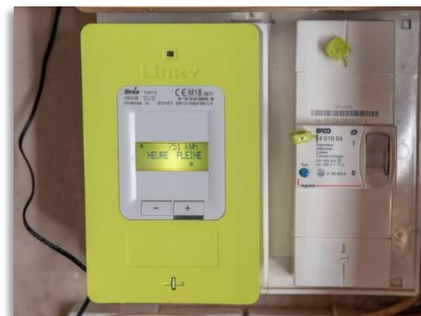
Compteur électrique Linky
